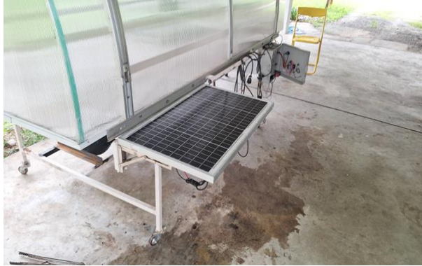
รูปภาพที่ 3.14 ลักษณะการติดตั้งแผงโซล่าเซลล์ของโรงอบตาก
