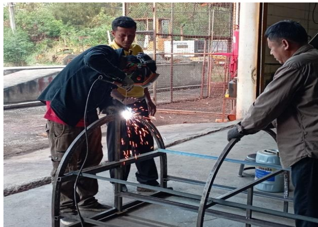
รูปภาพที่ 3.5 การสร้างประกอบชุดโครงสร้างด้านบน
