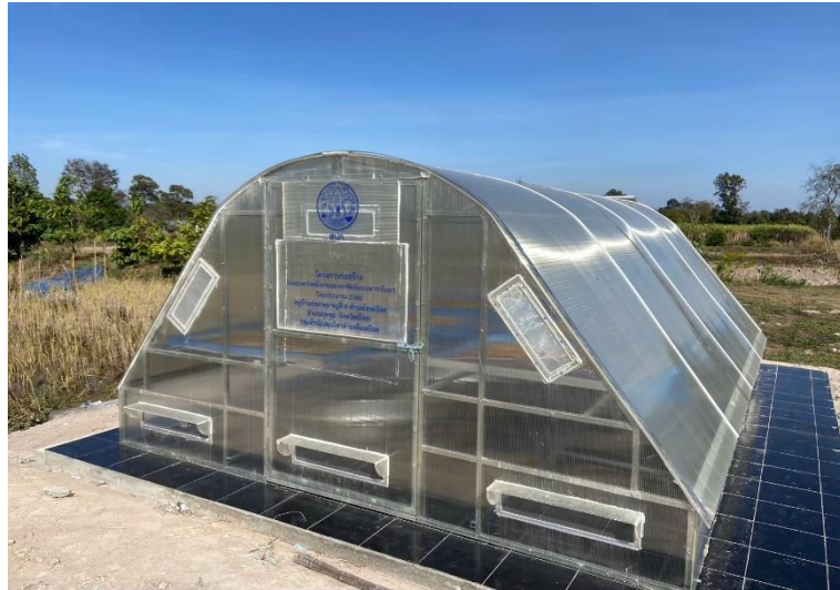
รูปภาพที่ 2.17 โรงอบตากพลังงานแสงอาทิตย์ แบบพาราโบลา
